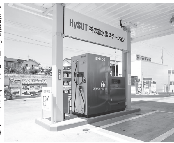
名古屋市中区「ENEOSサービスステーション神倉」では、ガソリンスタンド一体型水素ステーションの実証実験中
